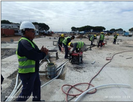
Colocación de Bases L868 empotradas
