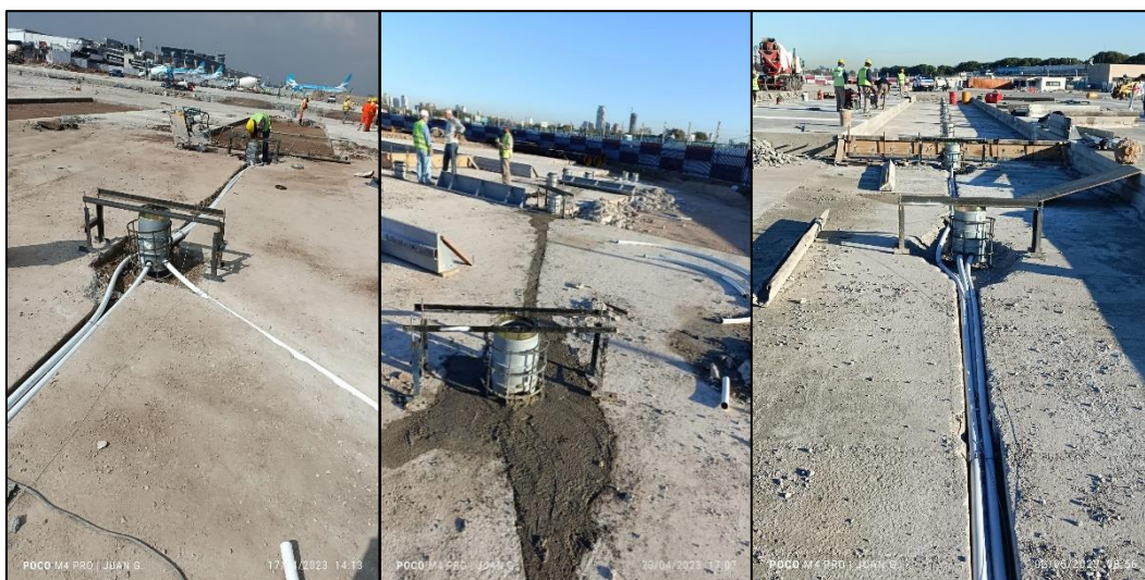
Canalizaciones y bases L-868 par a acometidas primarias (instalación en 3 etapas)
