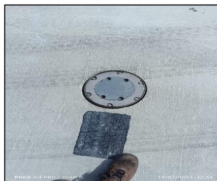
Base L-868 con adaptador y tapa ciega Instalada
