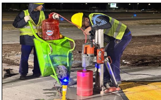
Perforación de pavimento para instalación de balizas empotradas
