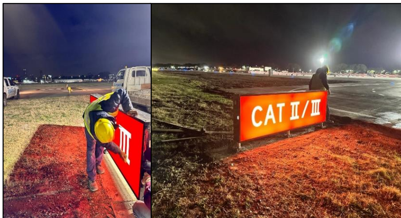
Instalación de letreros aeronáuticos
