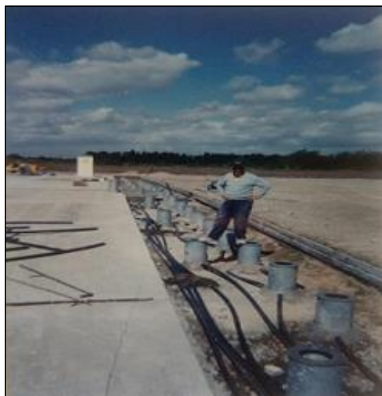
Instalación de bases L868 para balizas de umbral de pista
