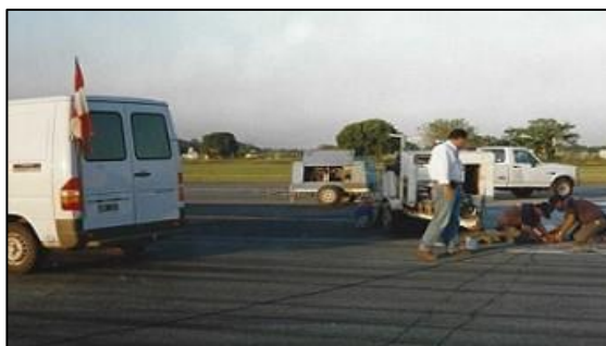
Instalación de Balizas empotradas
