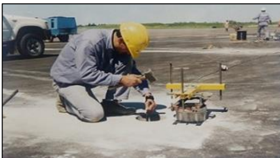
Instalación de Balizas empotradas
