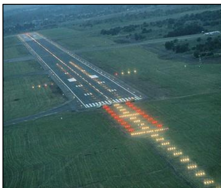
Luces de pista y aproximación
