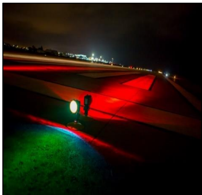
Luces de umbral y fin de Pista
