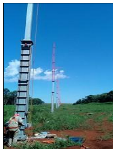
Instalación de Mástiles
