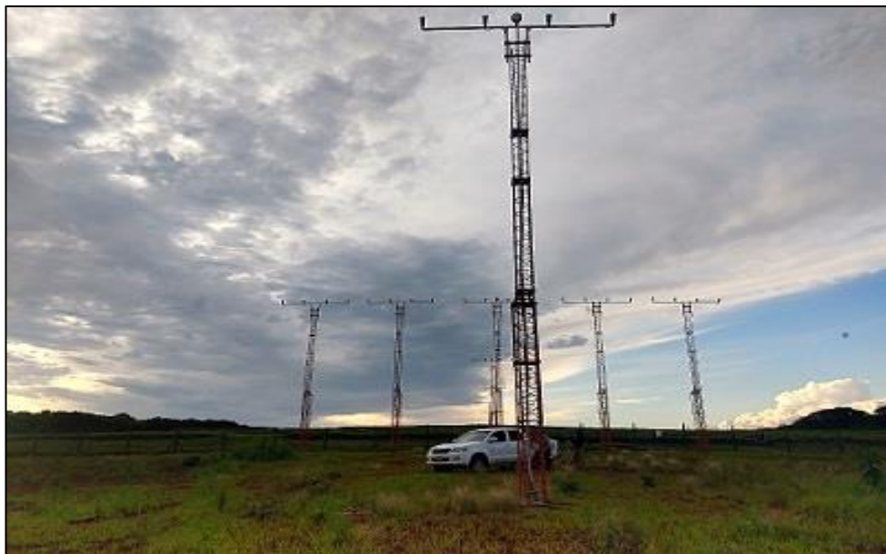
Instalación de Mástiles. (Barra de 300 m al fondo)
