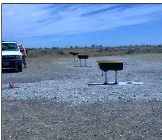
Instalación de Luces de PAPI
