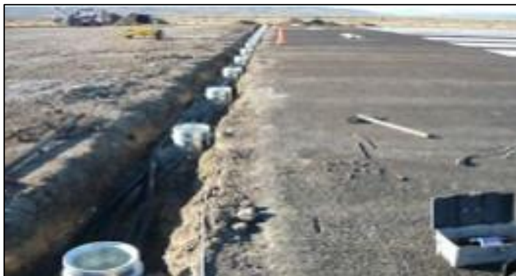
Instalación de bases L-868 para luces de umbral de pista
