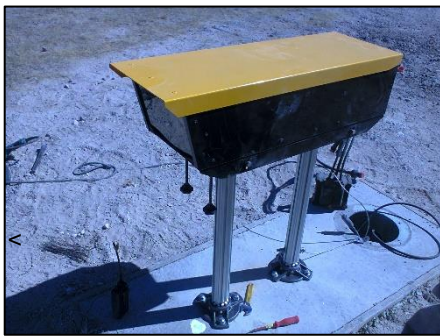
Instalación de Luz PAPI
