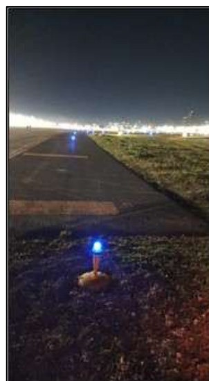
Luz de borde de rodaje instalada
