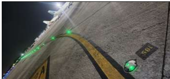
Balizas de eje de rodaje instaladas
