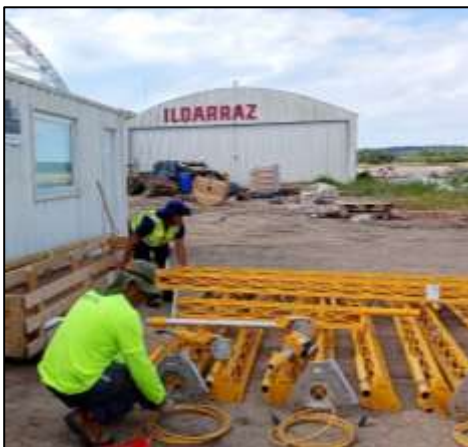
Preparation of masts for ALS lights
