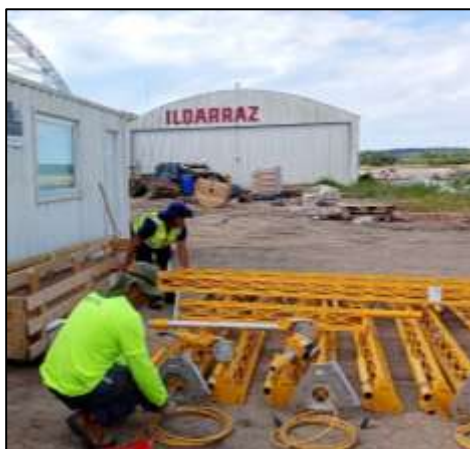
Preparación de mástiles para luces ALS
