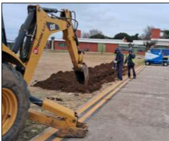
Zanqueo a máquina para acometidas de cables primarios
